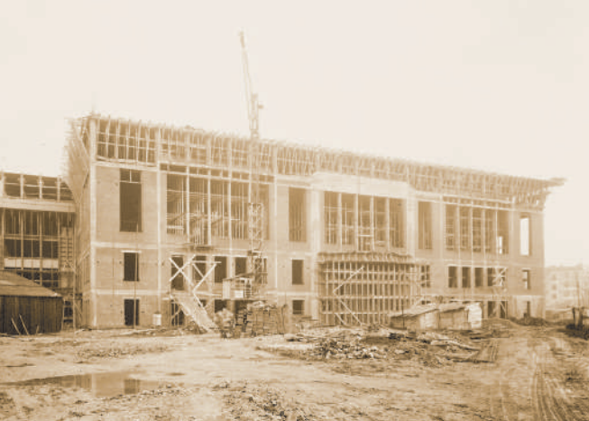
L'hôtel de ville en construction, façade principale
